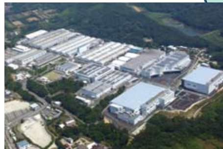
川崎重工西神戸工場 Nishi-kobe Works
